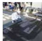
吸着マットによる漏 洩物の回収
