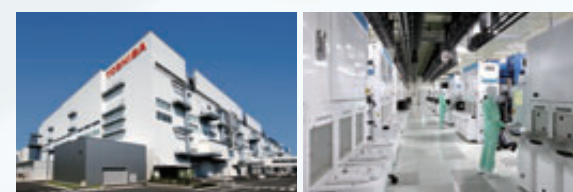
四日市工場 新・第2製造棟 四日市工場 新・第2製造棟 (グリーンルーム内)
